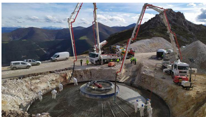
Obras del parque de Capital Energy en Buseco Capital Energy
