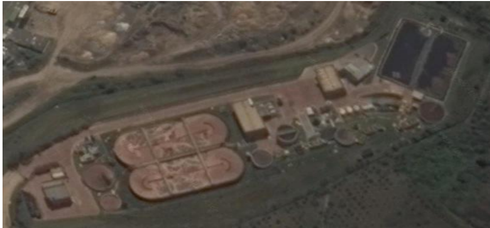
Ilustración 4. Planta de tratamiento de lixiviados
